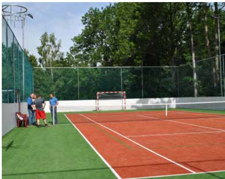
Terénní úpravy stávajícího sportovního hřiště, realizoval Josef Šefc, Chata Juráška v Olešnici v Orlických horách.
